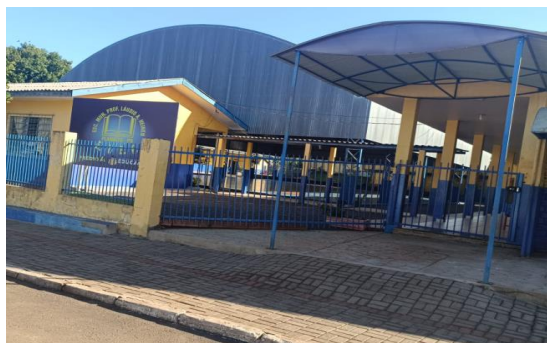
Entrada da escola- Prédio A
