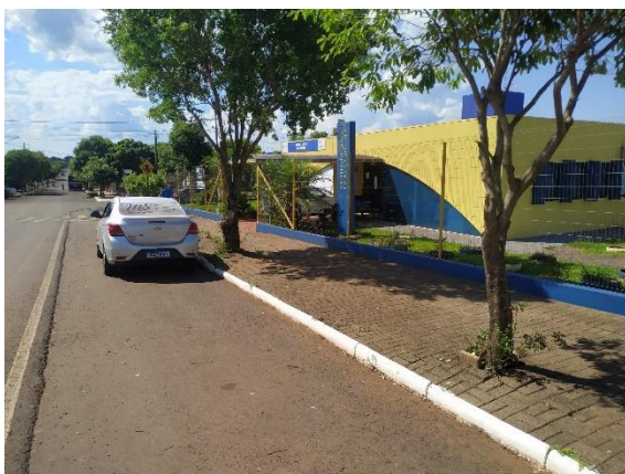
Figura 2.10. Acesso a UBS Bairro João Zacco
