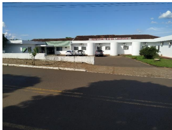
Figura 2.9. Acesso Hospital Nossa Senhora de Lurdes
