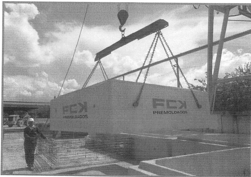
Figura 2: manuseio de galeria com utilização de cambão mais correntes mais pinos.
