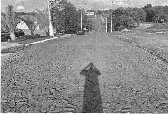
Rua nº 4 - Trecho II
